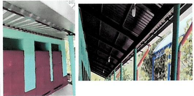
Foto 6: Instalación de estructura metálica y cambio de lámina por lamina troquelada.
